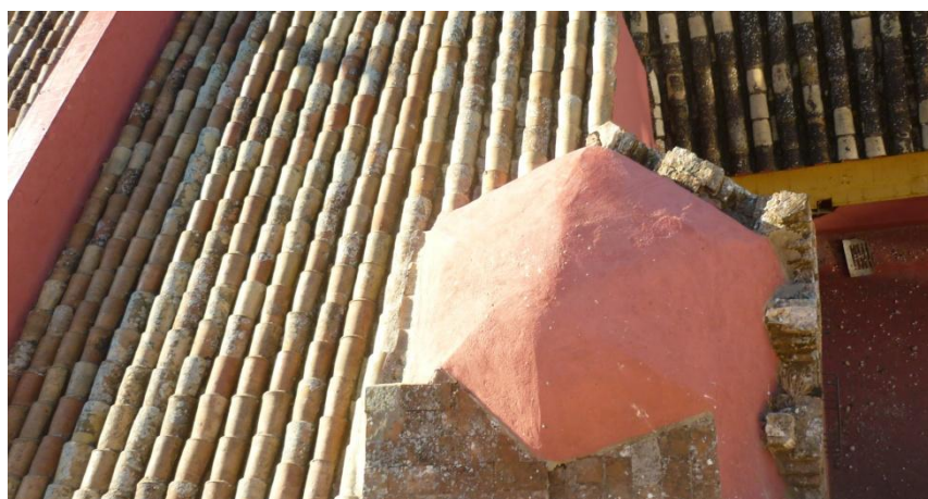
Detalle de cubierta y su encuentro con el cupulín
