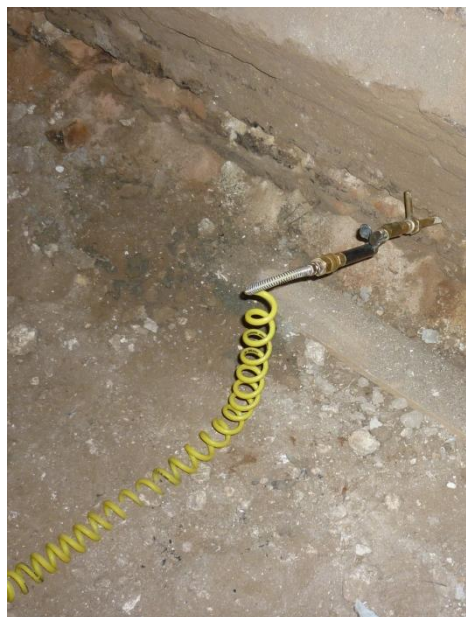
Inyección de productos impermeabilizantes
