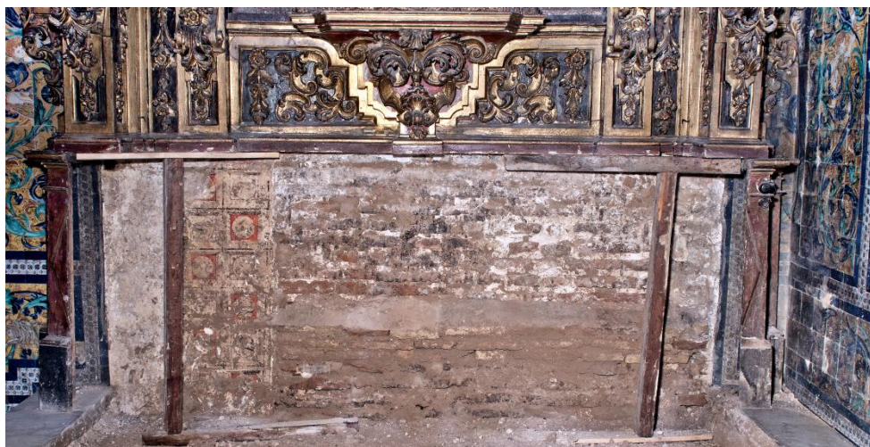
Tras el desmontaje del altar han aparecido restos de pintura mural en forma de mosaico en la izquierda, y el arranque de una bóveda de cañón en la zona derecha
