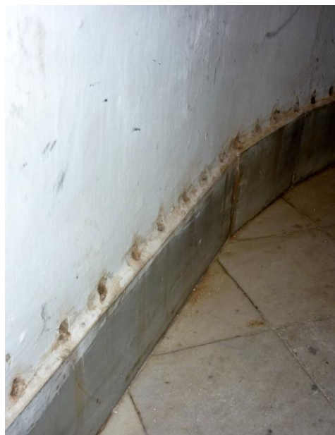
Perforaciones realizadas en el muro oeste para la aplicación de productos impermeabilizantes
